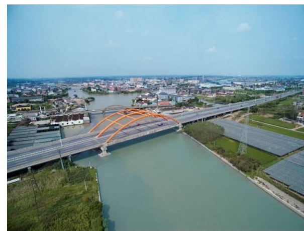
嘉兴至海盐南北湖公路于城大桥
